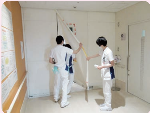
防火防煙スクリーンを確認している様子
